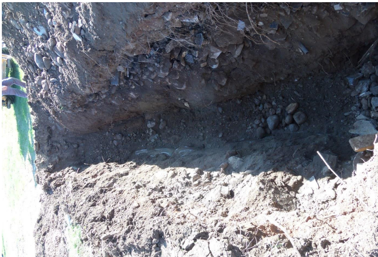
Foto 5: zona di ancoraggio sponda destra (lato Dronero) – indagine geognostica
