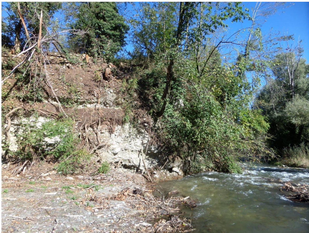
Foto 2: zona di ancoraggio sponda sinistra (lato Villar San Costanzo)
