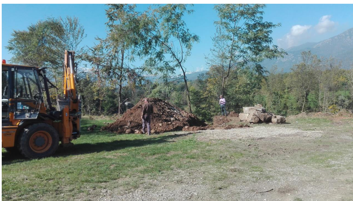
Foto 4: zona di ancoraggio sponda destra (lato Dronero) – indagine geognostica
