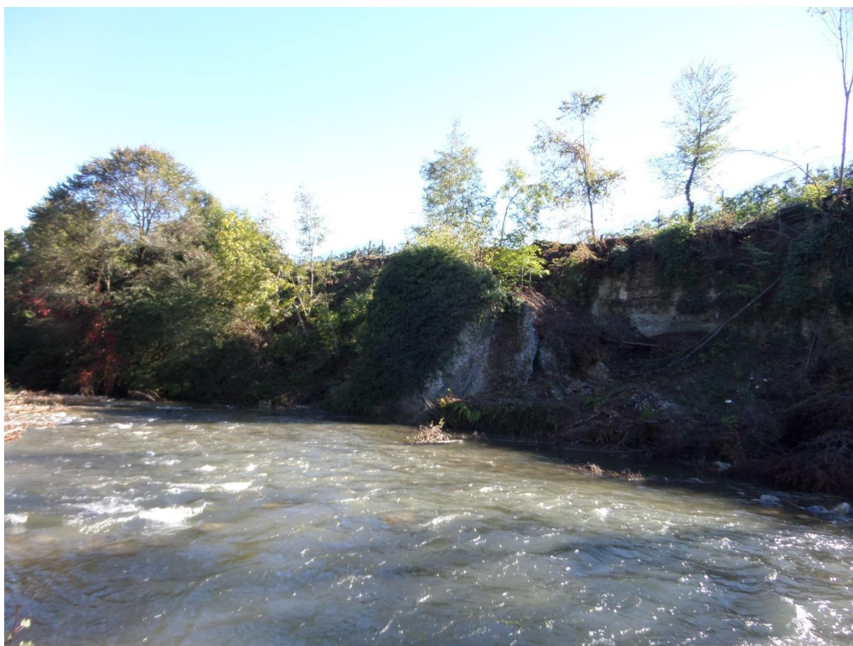
Foto 3: zona di ancoraggio sponda destra (lato Dronero)
