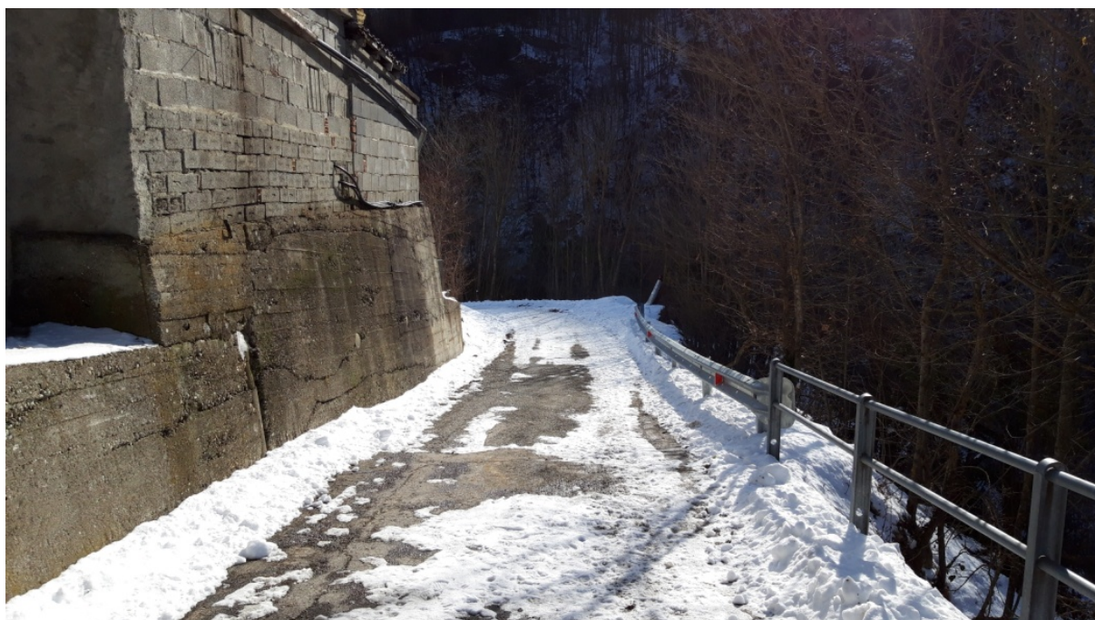
Figura 1 - Vista dell'intervento 1 - zona a monte, lungo la strada comunale per la borgata Villetta
