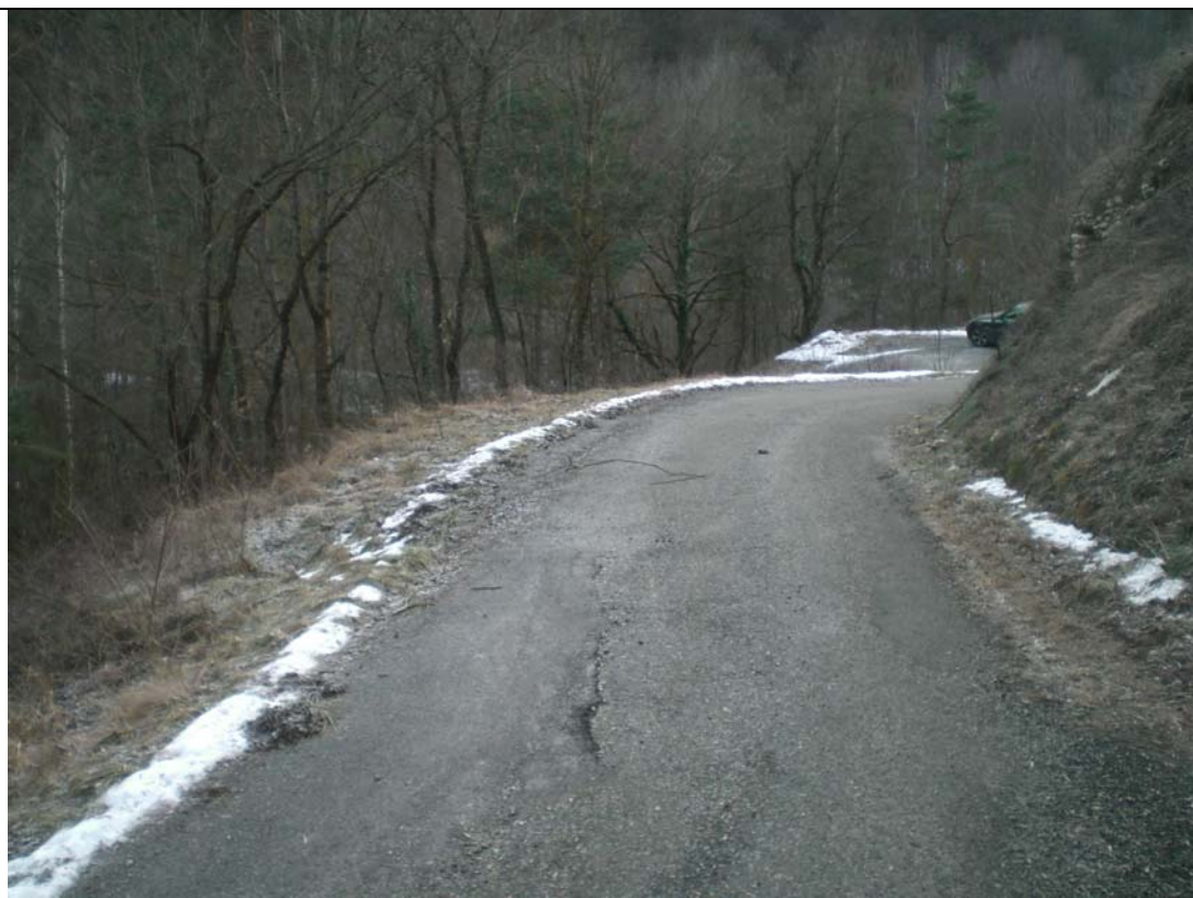
Figura 4 - Intervento 2 - Vista da monte del secondo tornante
