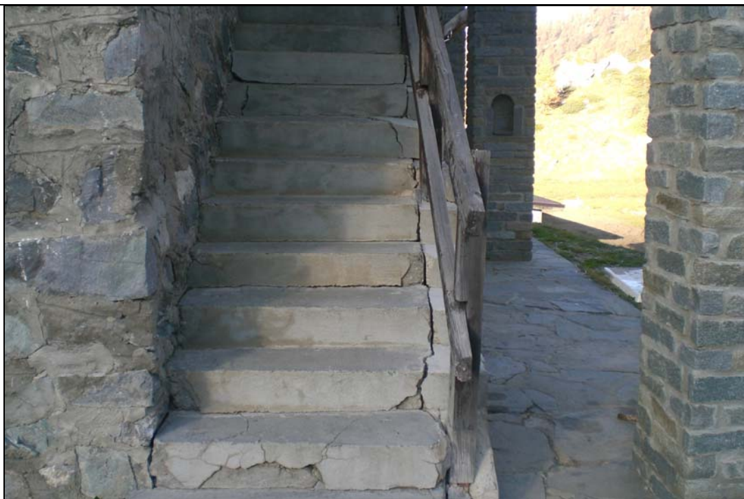
Foto n. 5: MALGA DI RESIDENZA – Vista della malga nella porzione in cui è previsto il rifacimento della scala di accesso al primo piano.
