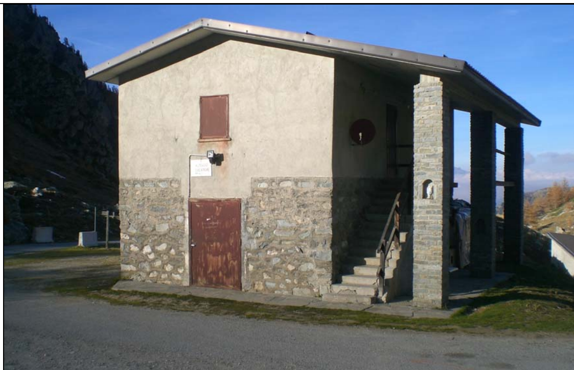
Foto n. 3: STALLA DEL BESTIAME – Vista della parte anteriore dell'edificio con particolare della pavimentazione oggetto di intervento.
