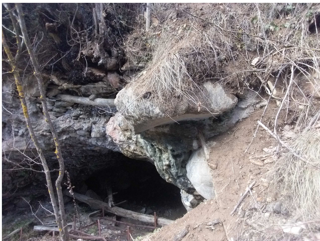
Imbocco cavità nei conglomerati parte sinistra idrografica
