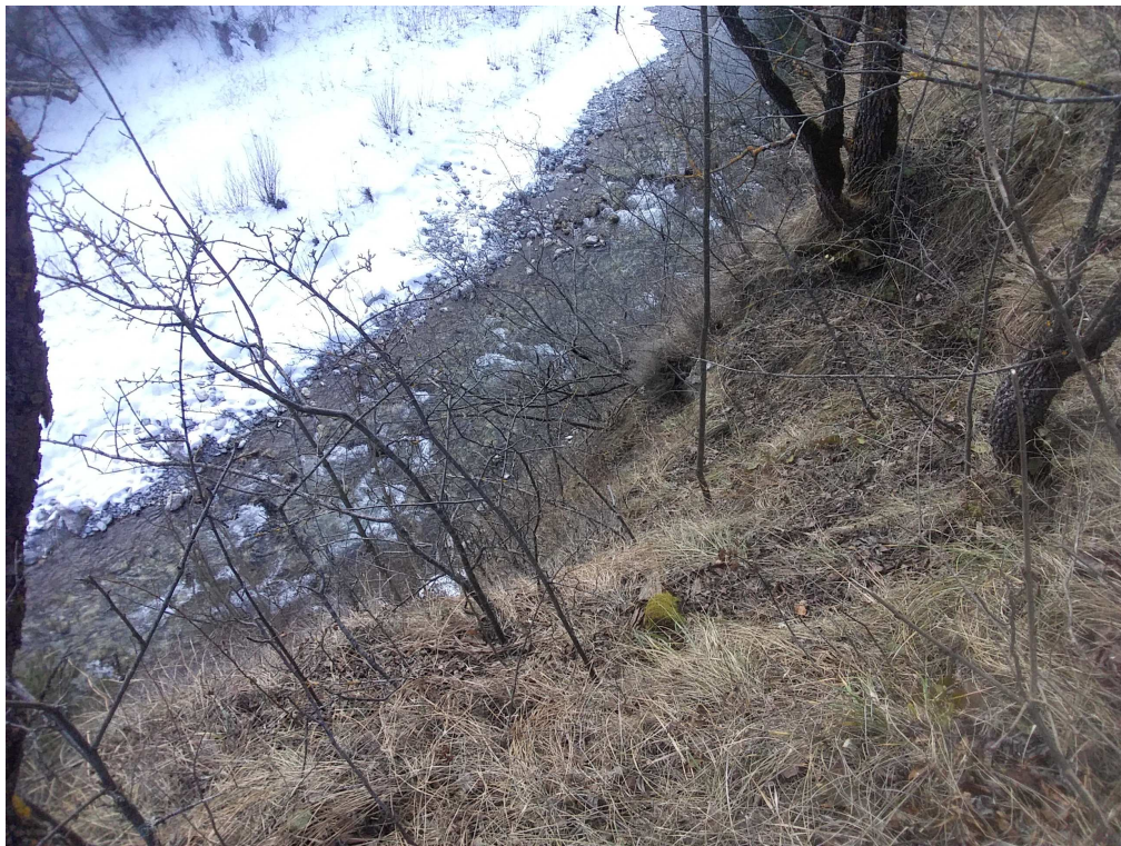
Scarpata subverticale di raccordo con l'alveo del T. Maira
