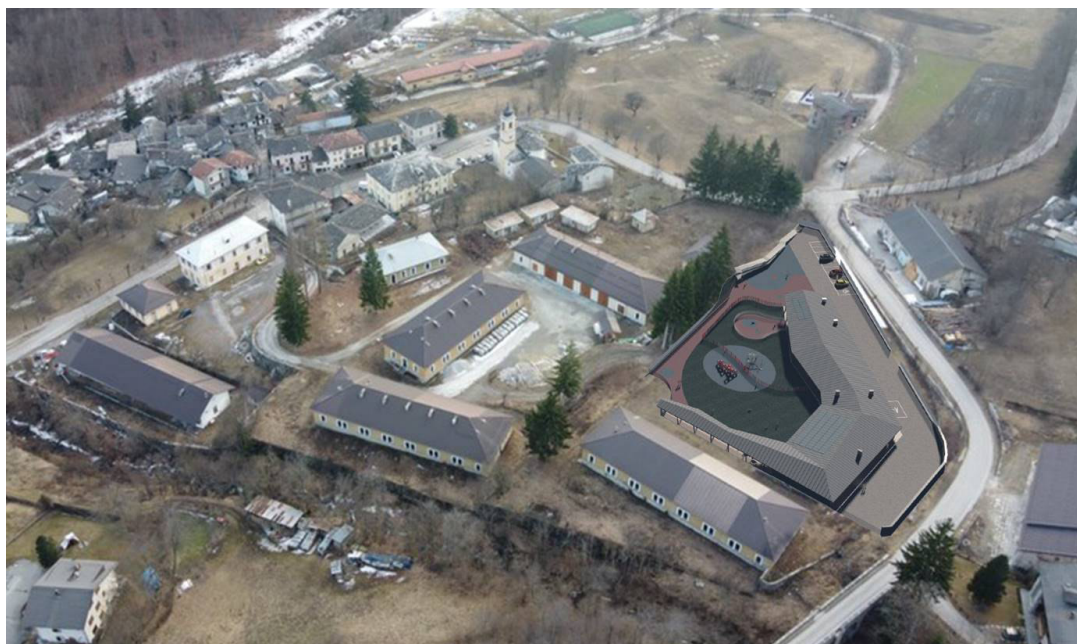
Vista dall'alto dell'intervento complessivo
