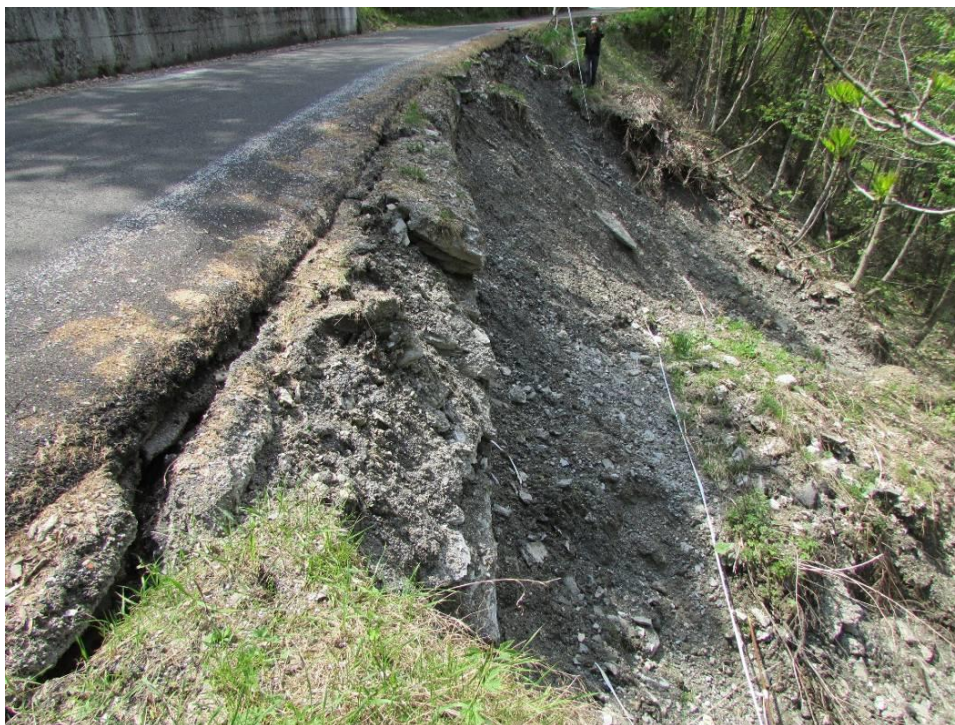
VISTA DI DETTAGLIO DELLA FRANA A MONTE - a seguito del dissesto è rimasto scalzato ed in parte franato il vecchio muro di sostegno della carreggiata in pietra
