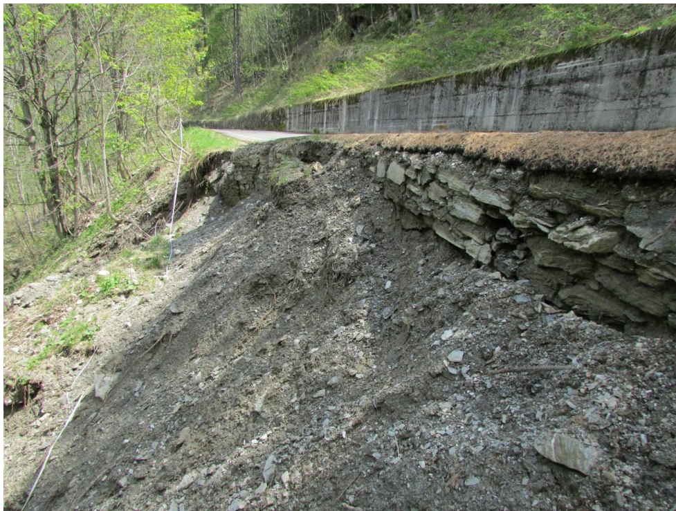
VISTA DI DETTAGLIO DELLA FRANA A MONTE - a seguito del dissesto è rimasto scalzato ed in parte franato il vecchio muro di sostegno della carreggiata in pietra
