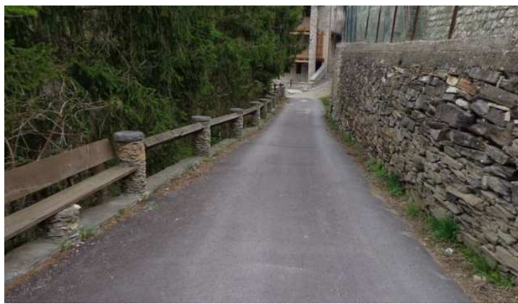
PARTICOLARE STRADA A VALLE DEL MURO NON PRESENTA SEGNI DI CEDIMENTI O ASSESTAMENTI
