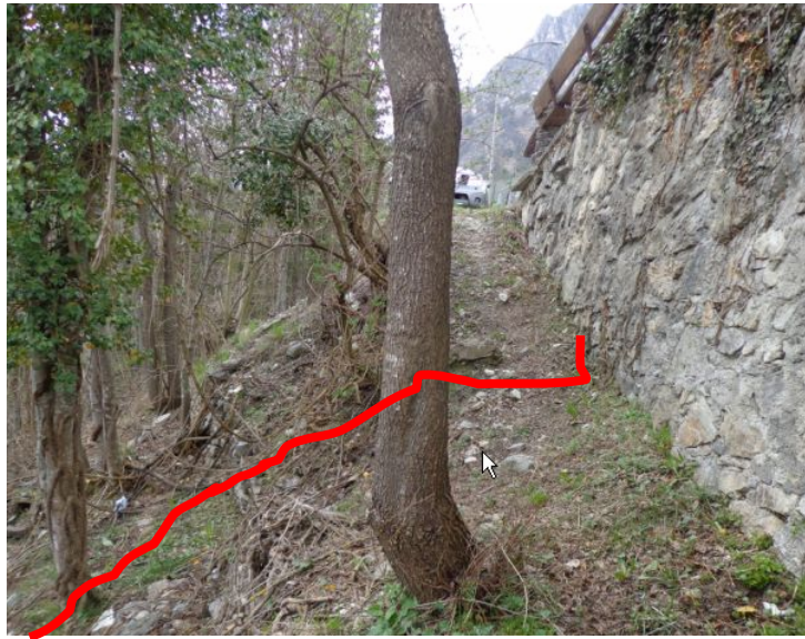
particolare pendenza del pendio naturale a valle del campo da bocce probabile presenza di conglomerato cementato come rilevato in altre zone come bedrock per questo motivo il versante si trova in generale in una situazione di stabilit 
