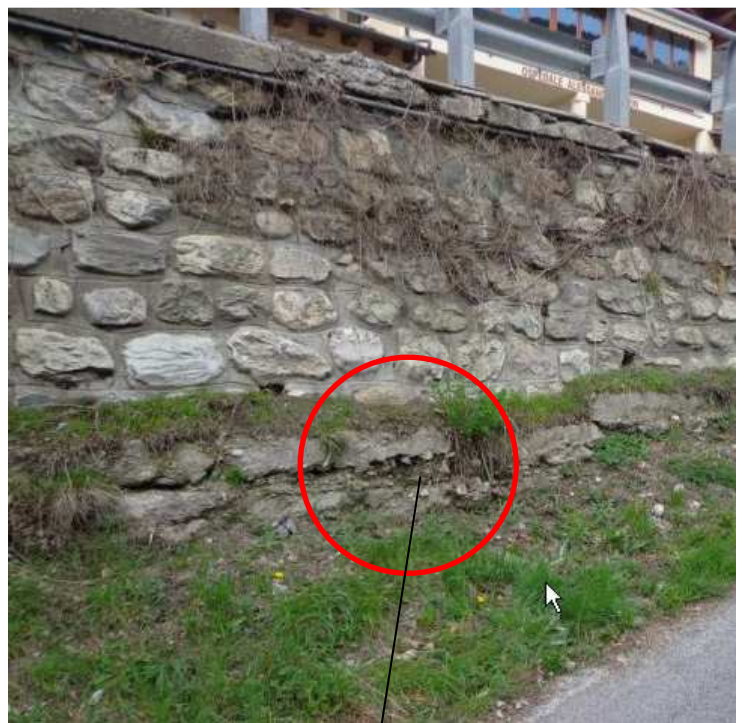
PARTICOLARE STRADA A VALLE DEL MURO NON PRESENTA SEGNI DI CEDIMENTI O ASSESTAMENTI
