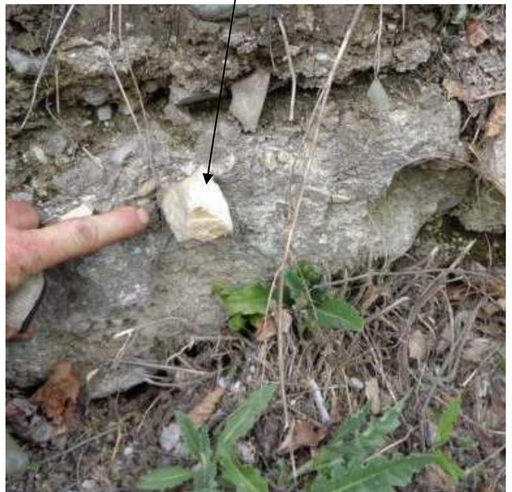
particolare deposito sedimentario cementato di appoggio al muro della statale
