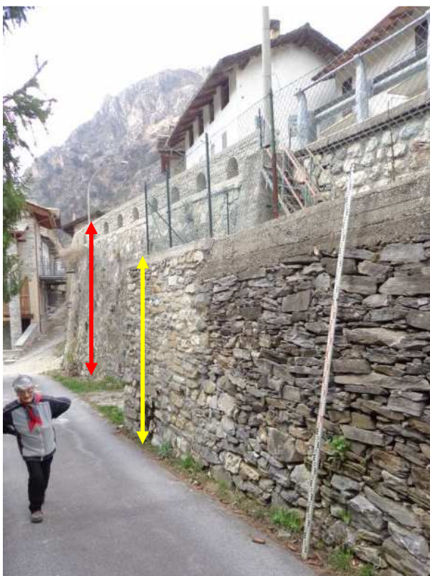
FRECCIA ROSSA altezza variabile del muro della statale
