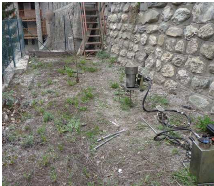
Prova penetrometrica 2 eseguita vicino alla scaletta Entrambe le prove hanno rilevato la presenza di terreno di riporto per tutto lo spessore del muro
