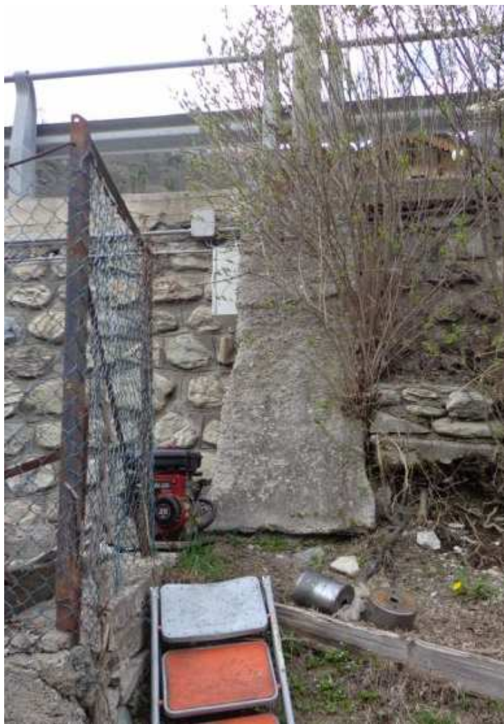
PARTICOLARE APPOGGIO INESISTENTE DEI PALI DELL'ILLUMINAZIONE PUBBLICA.
