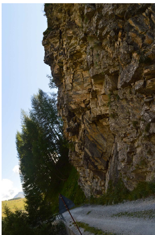
Fig. 8 versante roccioso nelle vicinanze del ponte
