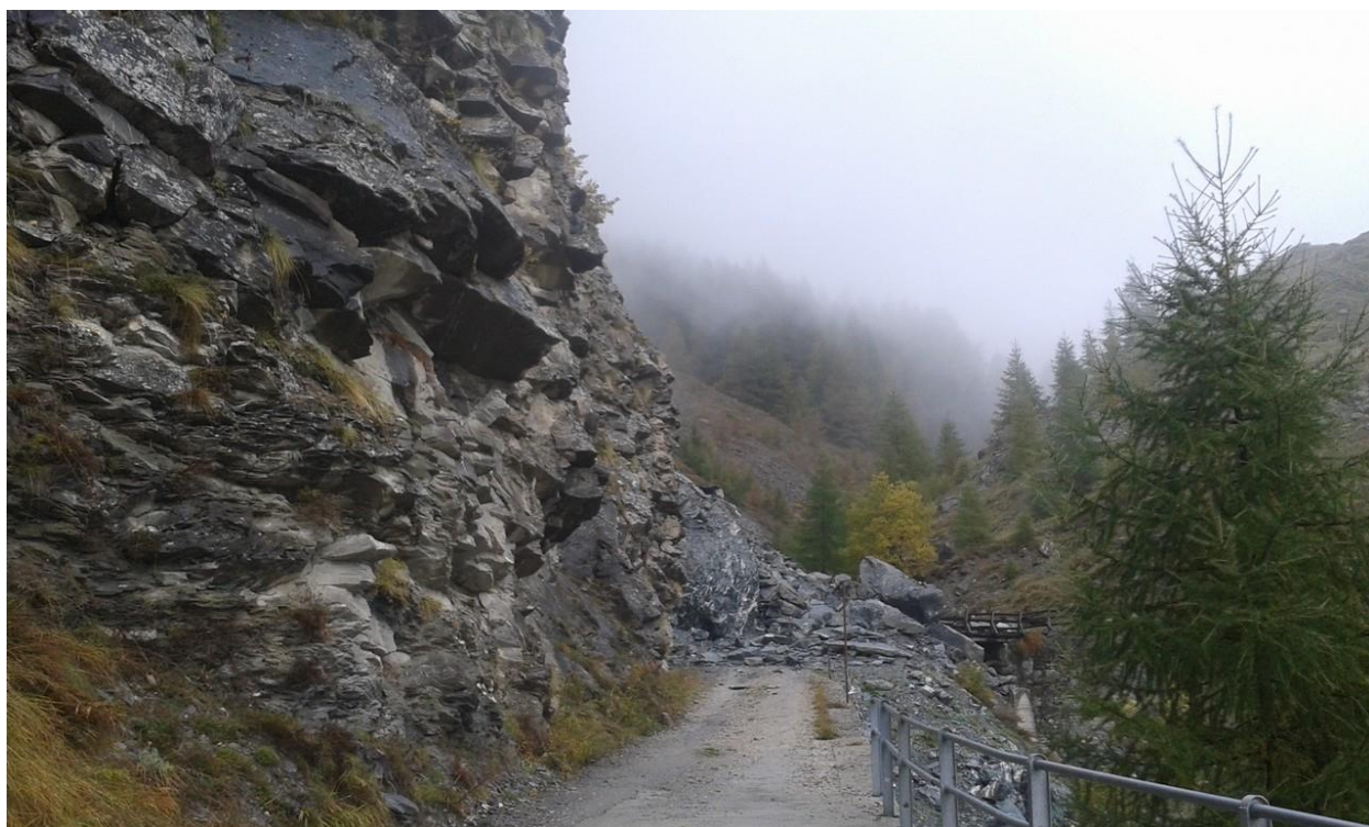
Materiale accumulatosi sul sedime stradale (vista da valle)
