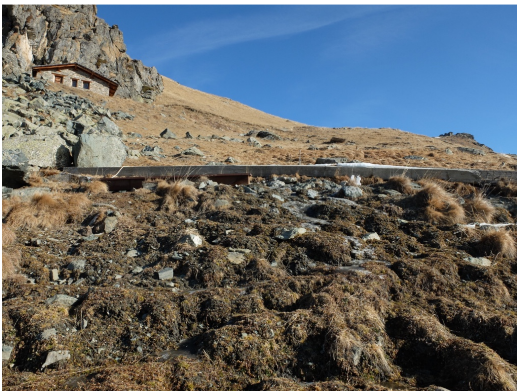
Foto n.2 – Visione d'insieme con l'abbeveratoio in cemento in primo piano e la grangia a monte.
