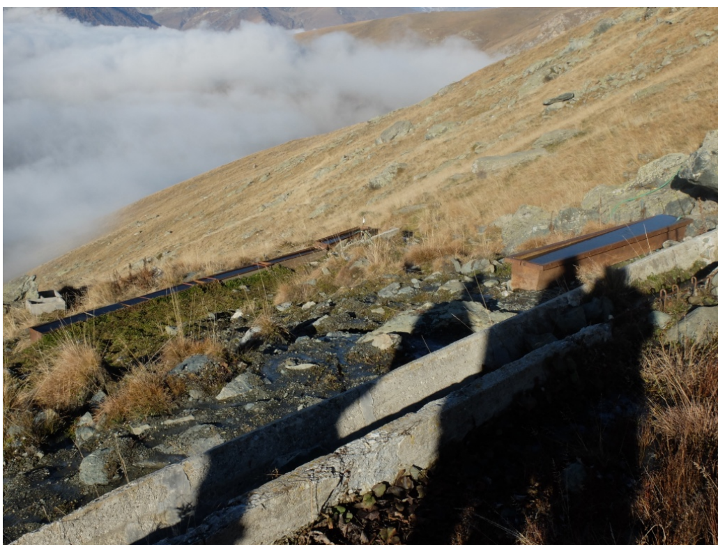
Foto n.8 – Vista sugli abbeveratoi, in primo piano quello in cemento e più a valle quelli in lamiera.
