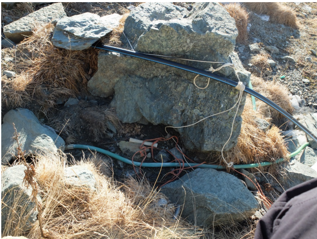
Foto n.11 – Pozzetto di presa con le tubazioni fuori terra.
