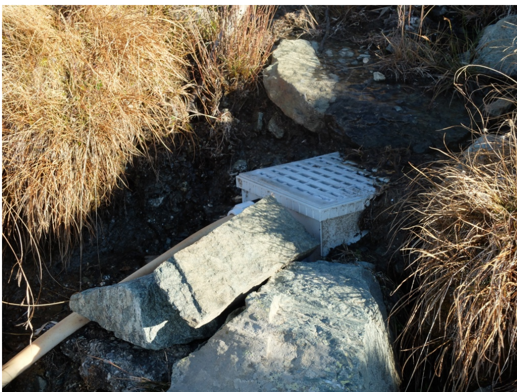
Foto n.14 – Particolare del pozzetto con griglia.
