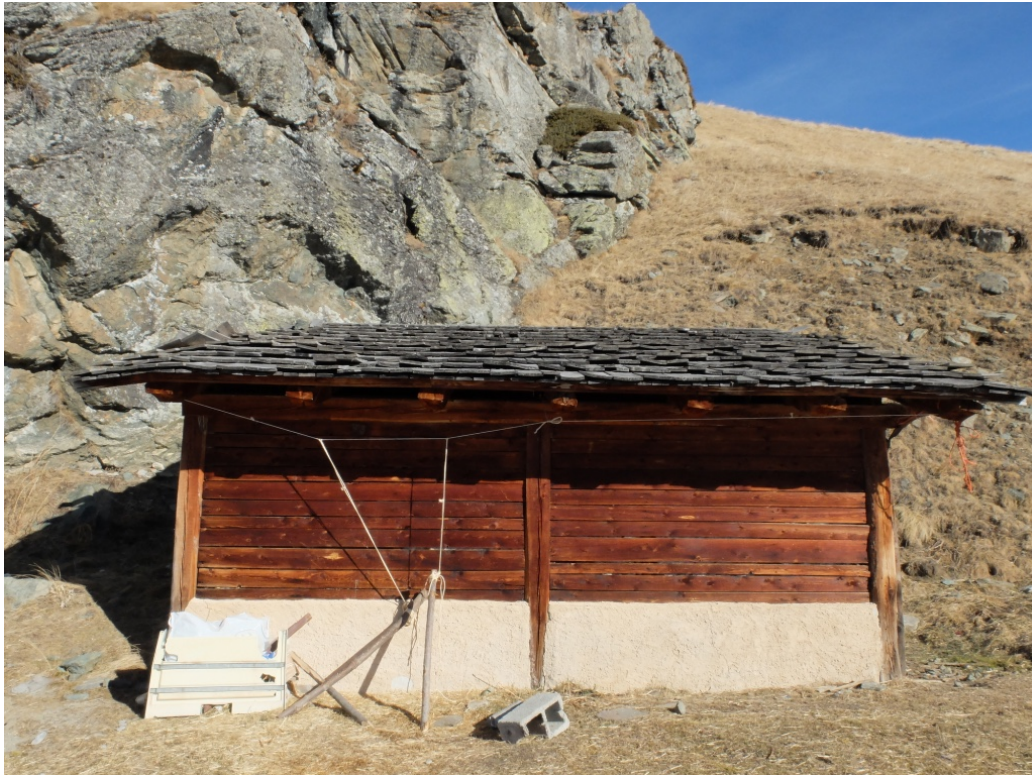
Foto n.5 – Vista sul ricovero, da valle.
