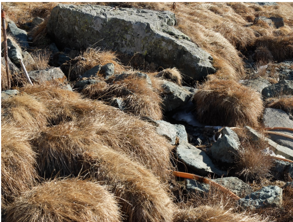
Foto n.15 – Vista dei tubi che si dipartono dal pozzetto con griglia e che alimentano gli abbeveratoi.
