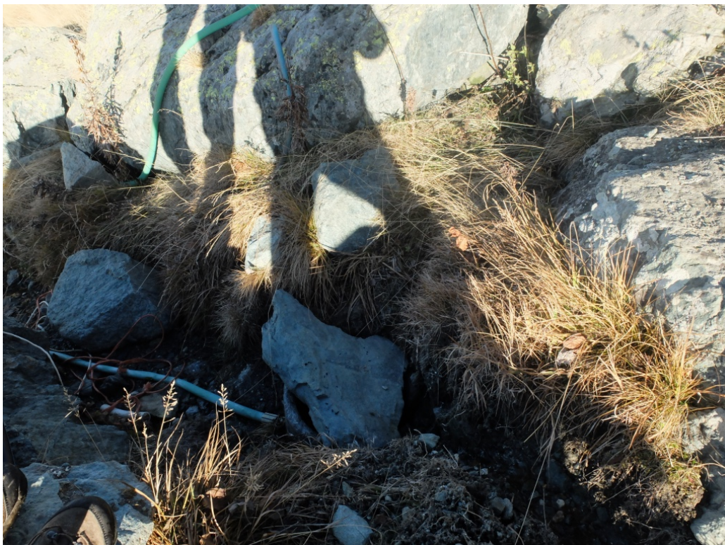
Foto n.12 – Vista del pozzetto da monte.
